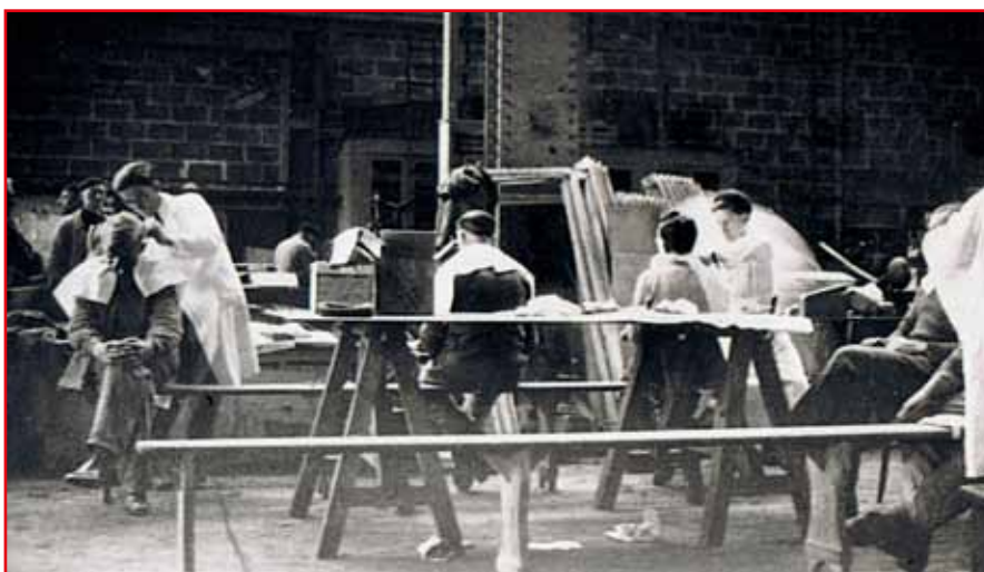
Photo : CHT. SC 6424. "Coiffeurs d'usine" aux Chantiers occupés à Saint-Nazaire.
